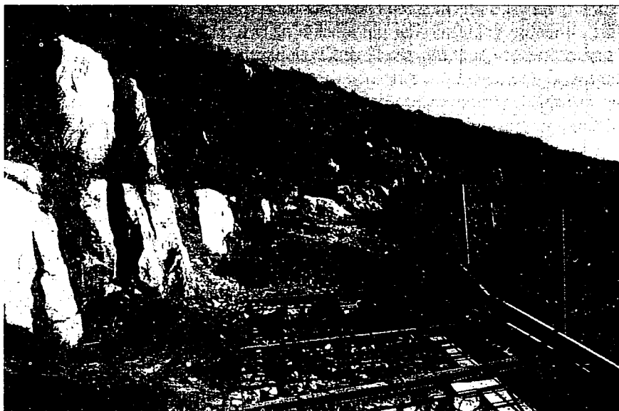
- Sul costone della Malacoccola, tra Torca e Colli delle Fontanelle, sorge una strada abusiva con opere in cemento armato per lo scavalcamiento del Torrente Rimaiuolo (gennaio 2000).
